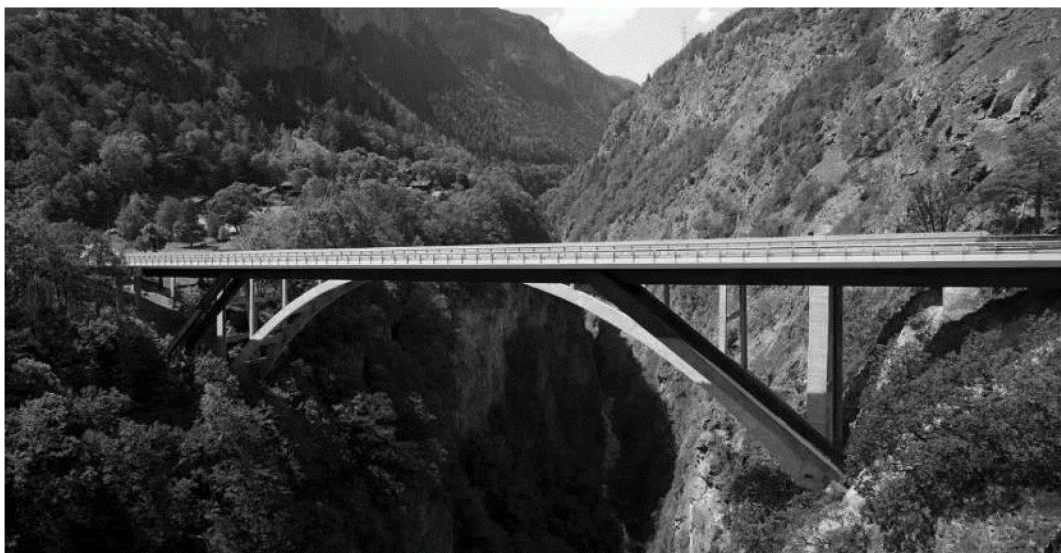
Fig. III.9 Pont de Gueuroz après la juxtaposition du nouvel ouvrage, VS. © Commune de Vernayaz
