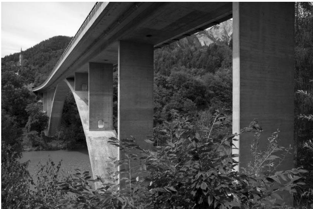
Fig. III.2 Rheinbrücke Reichenau (Oberalpstrasse), GR. © Ikiwaner / Wikimedia Commons ID : 213022.
