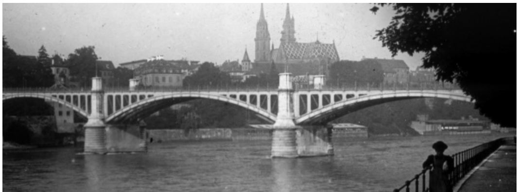
Fig. III.10 Wettsteinbrücke Basel, BS : ancien pont après le premier élargissement, photo prise après 1939. Source : Stéréo-Club Français (libre de droit)
