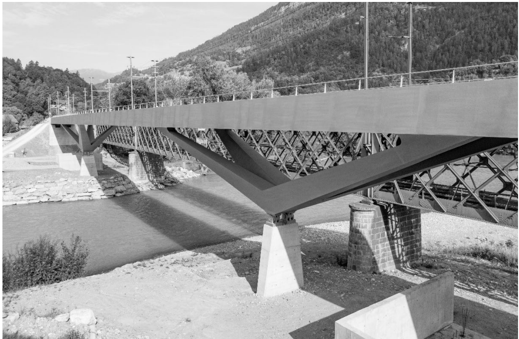
Fig. III.7 Hinterrheinbrücke Reichenau, GR. © Corporation WaltGalmarini.
