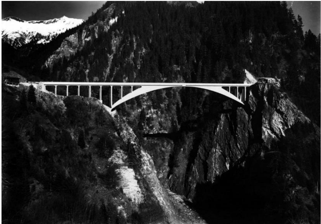
Fig. III.3 Pont sur la Gorge de Salgina (Salginatobelbrücke). © Collection : ETH-BIB Bildarchiv.
