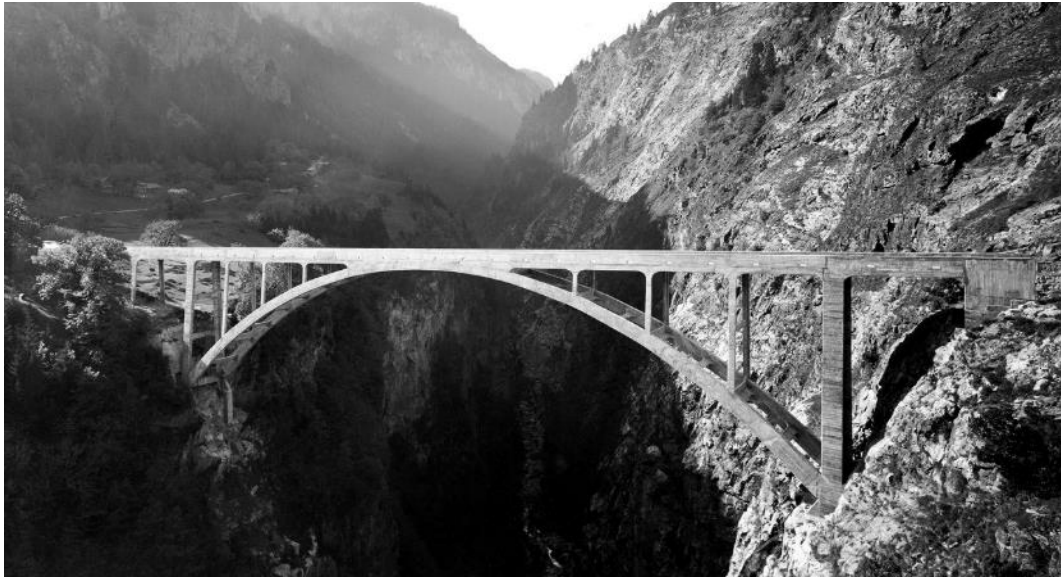
Fig. III.8 Pont de Gueuroz avant la juxtaposition du nouvel ouvrage, VS. © Commune de Vernayaz
